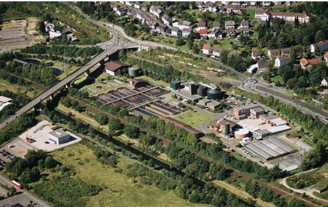
Im Einzugsgebiet der Sieg in Nordrhein-Westfalen werden die Abwässer in 82 Kläranlagen umweltschonend gereinigt. Die größte dieser Abwasserbehandlungsanlagen ist die Kläranlage Siegen. Sie ist ausgelegt für 175.000 Einwohner und kann bis zu 100.000 m<sup>3</sup> Abwasser pro Tag reinigen. Der Entsorgungsbetrieb der Stadt Siegen (ESi) sieht es als seine zentrale Aufgabe, mit moderner Abwasserreinigung den hohen Umweltaforderungen zu genügen.
