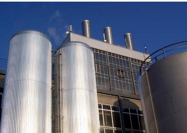
Die Universität Stuttgart betreibt ihr eigenes Heizkraftwerk. Das Heizkraftwerk Pfaffenwald versorgt die 30.000 Mitarbeiter und Studenten der Universität, Drittinstitute und 3.000 Studentenwohnungen mit Strom, Wärme, Kälte und Dampf. Zwei Gasturbinen, eine Dampfturbine sowie zwei Kraft-Wärme-Kopplungsblöcke erzeugen die dafür benötigte Energie.
